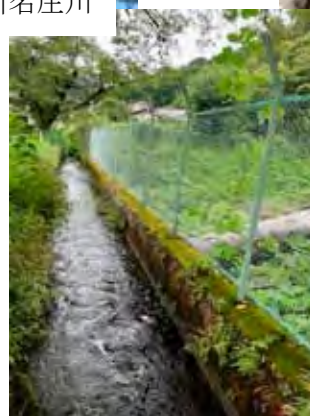
鹿留発電所上水路
