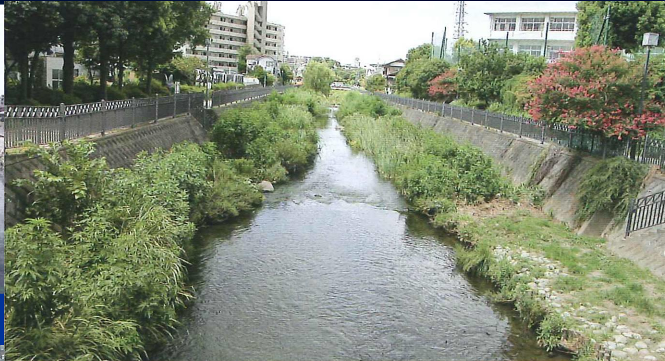
植生工法による補修後(2004)
