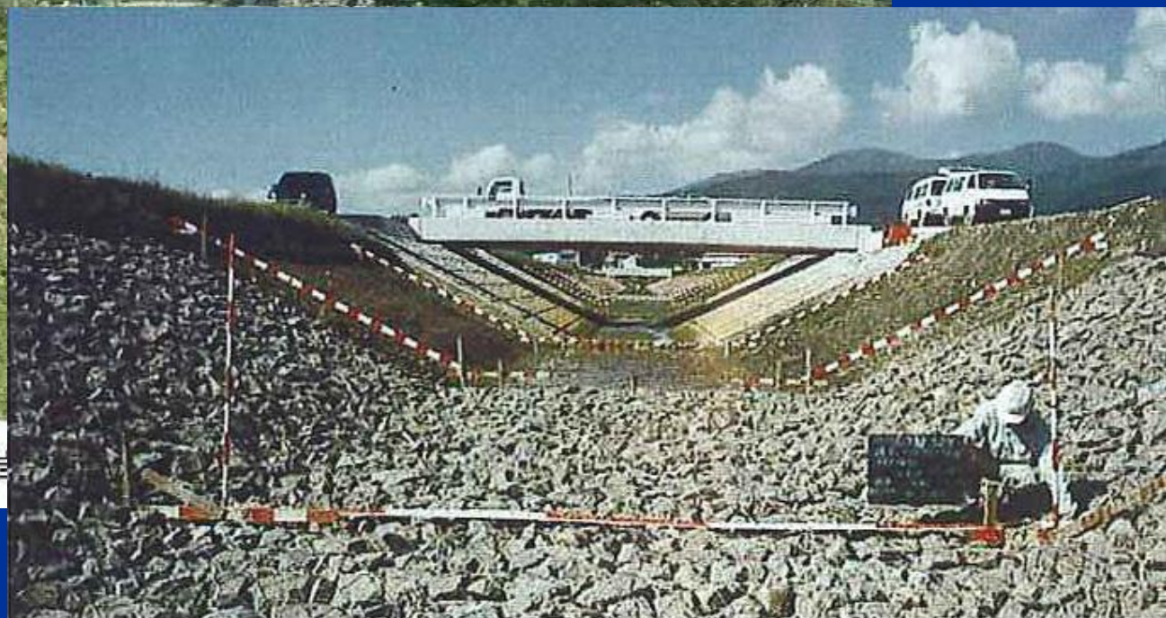
写真3 礫を用いた三面張り構造
