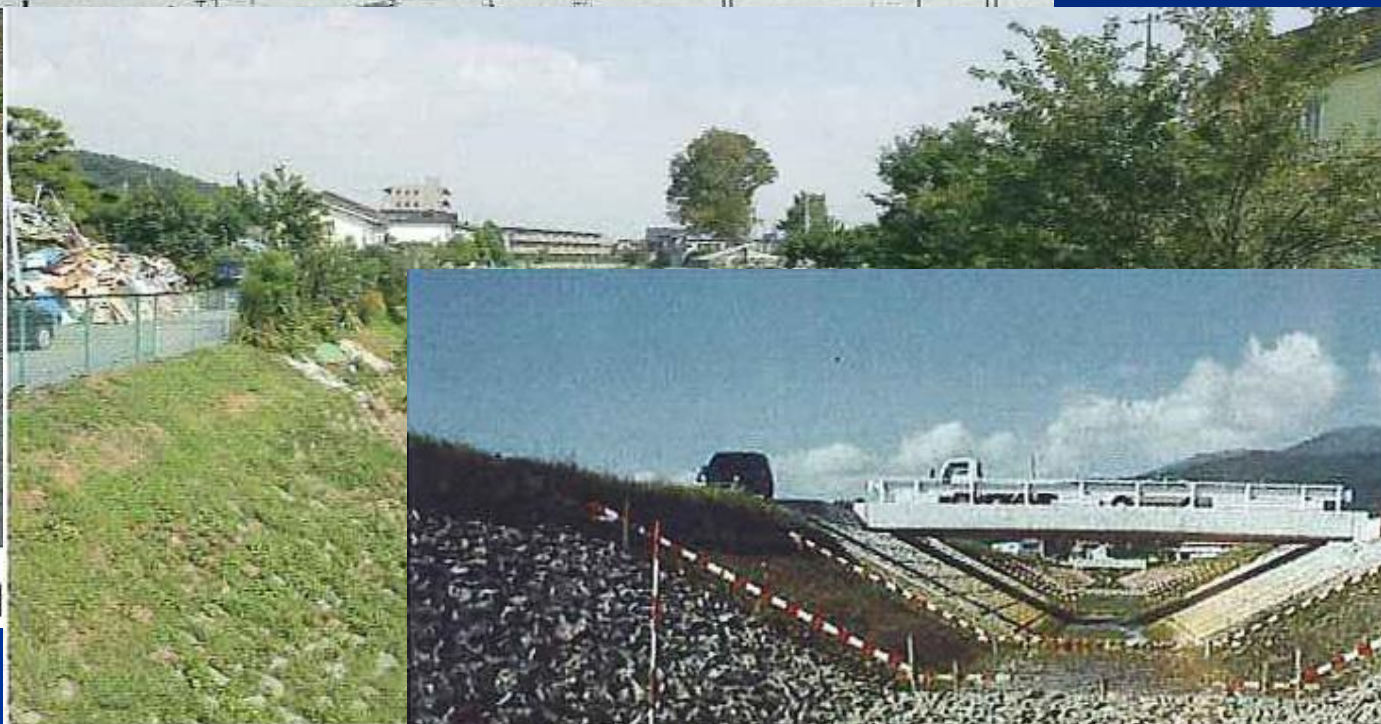
写真2 緩傾斜の護岸
