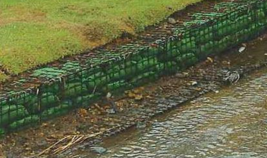
▲水際部を固定している例。時間が経つと自然な流れが失われる。
