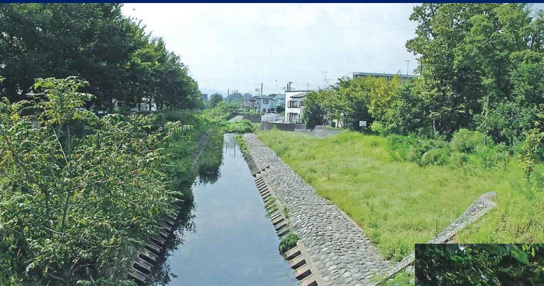
写真4 境川。旧河川敷を高水敷として整備した場所。広い空間があるが、定規断面で流路を敷広場になっている。
