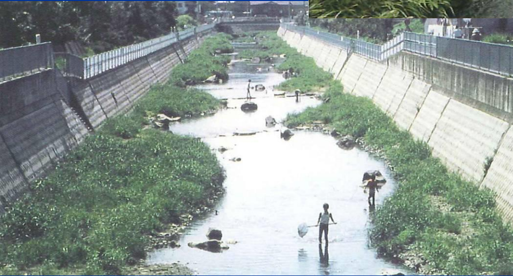
低水路施工直後(1984)
