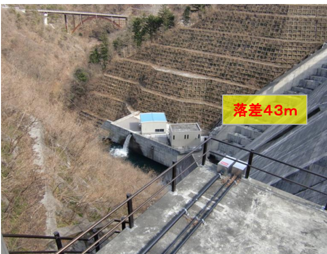
”昨年4月完成したばかりの小水力発電” 放流水の内1トンを活用、43mの落差利用
