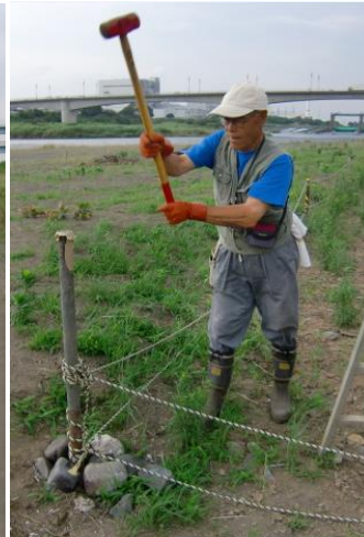
杭の打ち込み作業 脚立・ハンマーを準備され、安定するまで打ち込み。
