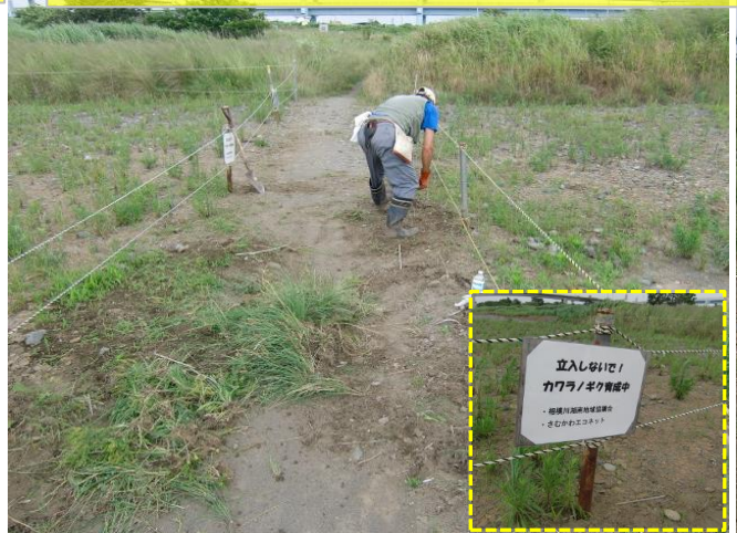
杭の打ち込み作業 脚立・ハンマーを準備され、安定するまで打ち込み。
