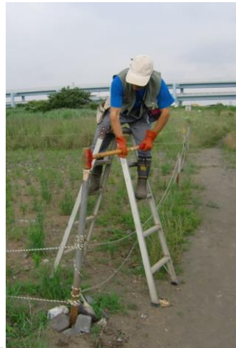
杭の打ち込み作業 脚立・ハンマーを準備され、安定するまで打ち込み。
