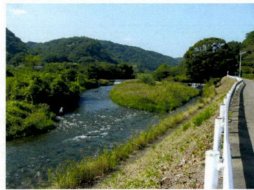
左・春芽吹き頃の尾山耕地遠景。右端に蛇行して流れる中津川。丹沢山塊東端の里山が湧水環境を生み出している 右・中津川坂本頭首工周辺
