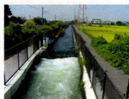
相模川左岸幹線用水路
