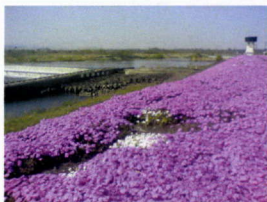
相模川磯部頭首工
